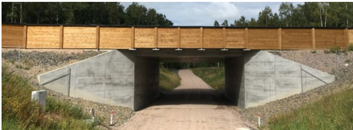
Figur C.1. Foto av plattrambro konstruerad och byggd 2020.
